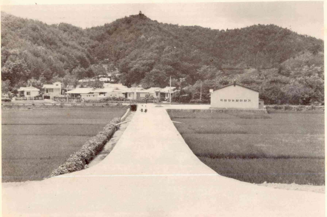
오 포 동 마을 진입로 포장 공사
